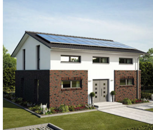
Energiesparer und Minikraftwerk in einem: Haus „Hamburg“ wurde bereits 2017 als Effizienzhaus 40 Plus entwickelt. Die Kombination von Photovoltaikanlage mit einem Batteriespeicher liefert einen Großteil der benötigten Energie für Heizung und Warmwasserbereitung
